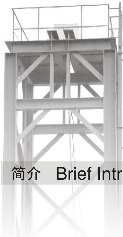
· 液压绞车试验井架
